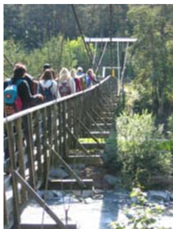
Le «Silserbruggli» des années 1920 ainsi que la deuxième passerelle Traversina sont conçus de manière à ce que des pièces puissent être remplacées sans mettre en péril leur stabilité.
