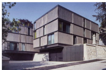
Trasformazioni dell'involucro esterno. In questo edificio, i diversi gradi di apertura dei vari strati della facciata permettono di creare situazioni poliedriche. (Edificio residenziale di agps.architecture, Zurigo).
