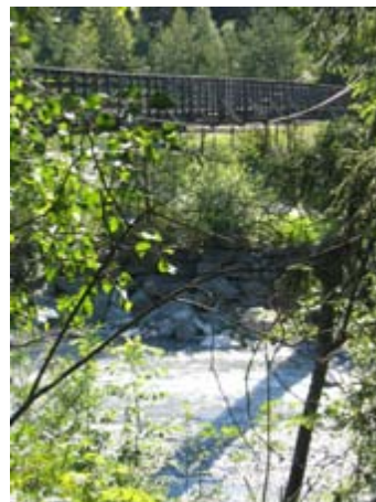
Il «Silserbrüggli» degli anni Venti del Novecento e il Ponticello sulla Traversina II sono costruiti in modo tale da poterne sostituire alcune parti senza comprometterne la stabilità.
