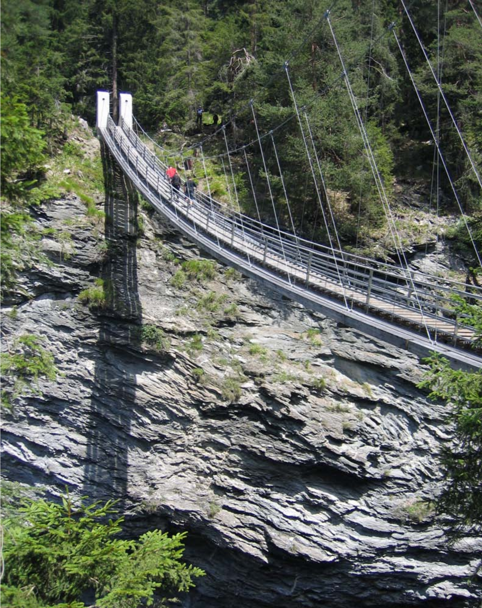
Percorrere e sperimentare il ponte «Ponticello sulla Traversina II», costruito nel 2005. Committenza: Associazione Kulturräum Viamala, ingegneri: Conzett, Bronzini, Gartmann, Coira. Nel 2006, questo ponte in legno e acciaio è stato premiato quale migliore opera architettonica dell'anno da una giuria della televisione svizzera e dalla rivista Hochparterre (si veda Hochparterre 12/2006).
