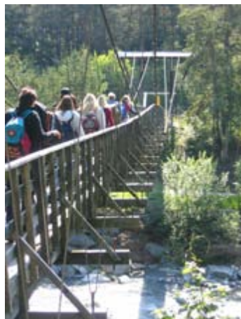
Il «Silserbrüggli» degli anni Venti del Novecento e il Ponticello sulla Traversina II sono costruiti in modo tale da poterne sostituire alcune parti senza comprometterne la stabilità.
